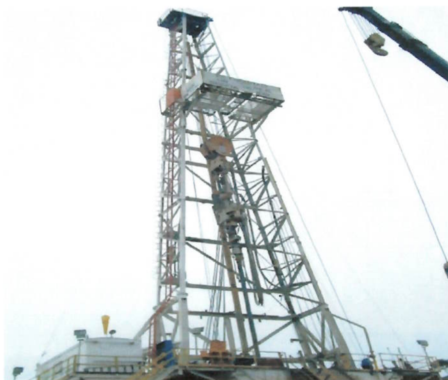
Figura 8 – Vista parcial da torre de Perfuração
